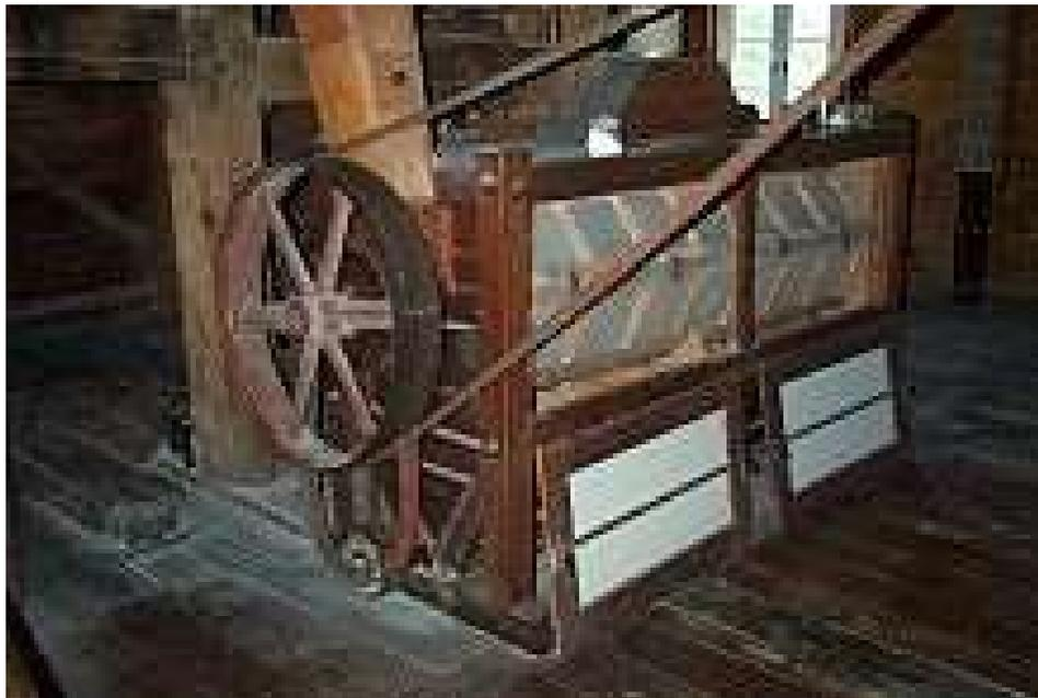
Le plansichter (machine à tamiser avec des tamis plans)
